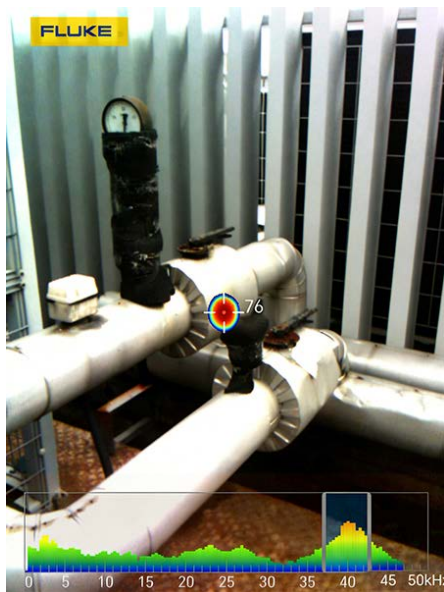
Leckerkennung an einer Pipeline
