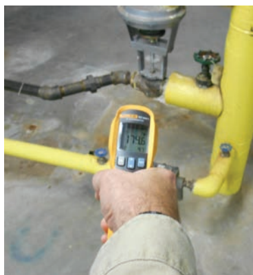
Überprüfung der Temperatur an der Kondenswasserleitung eines Kondensatabscheiders auf ordnungsgemäße Funktion.
