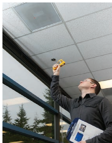
Luftaustrittstemperatur an Luftverteilungskanälen prüfen
