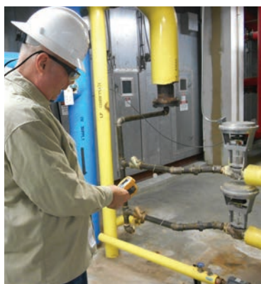
Prüfung des Kondensatabscheiders, ob er im geöffneten Zustand ausgefallen ist und Dampf unkontrolliert austritt.
