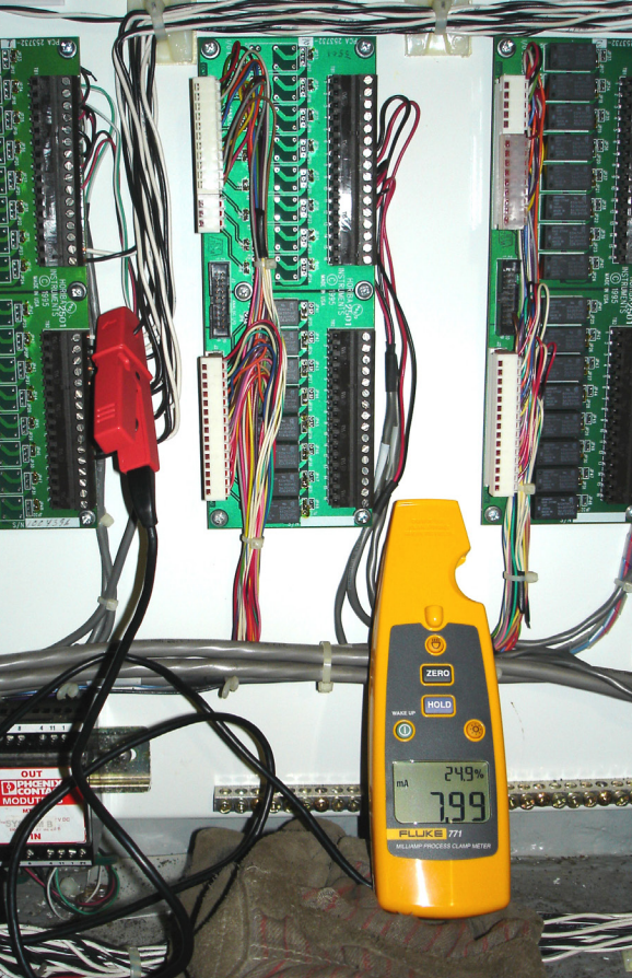
Abbildung 2: Bei bestimmten Anwendungen können die mit Fluke 771 ermittelten Prozentwerte hilfreicher sein als die zugehörigen Stromwerte – beispielsweise wenn ein Ausgang zur Steuerung innerhalb eines Bereichs von 25-30 % des Maximalwerts eingestellt werden muss. Hier wird mit Fluke 771 in der Stromschleife für Emissionswerte gemessen.
